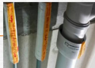
Brandschutz in einer anderen Dimension: Erhältlich in DN 32 bis DN 150.
