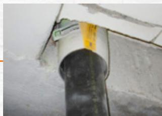
Abgestimmt auf die baulichen Gegebenheiten – einbaubar in Massivwände und leichte Trennwände  $\geq 100$  mm, Massivdecken  $\geq 150$  mm
